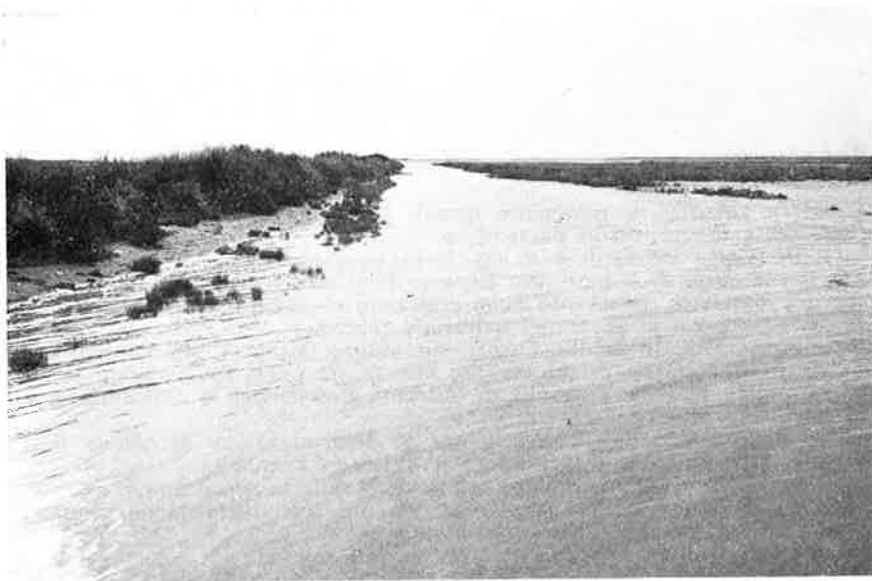
Fig. 8. Argine settentrionale; a destra, separata da un canale poco profondo, vi è una zona barenicola. (Foto: P. Canestrelli)
