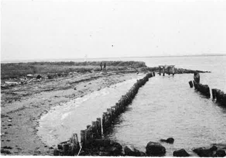
Fig. 4 - Argine nord-est della «Cassa B» con protezione a palificata.
