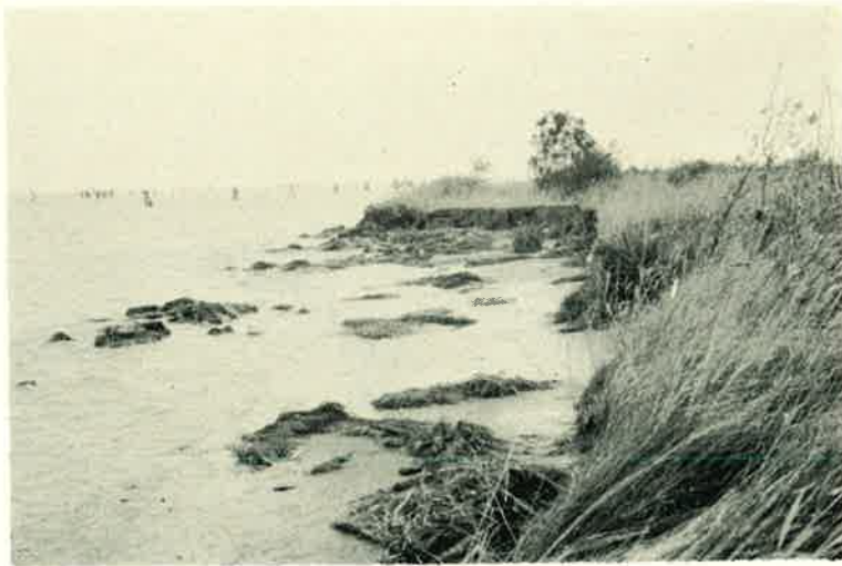
Fig. 6 - Tratto orientale della «Cassa B» confinante con il Canale dei Petroli. Si può notare l'erosione dovuta al moto ondoso.
